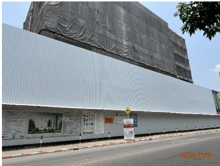
ภาพที่ 3.2.2-2 รั้ว Metal Sheet ตามแนวเขตพื้นที่ก่อสร้างโครงการ
