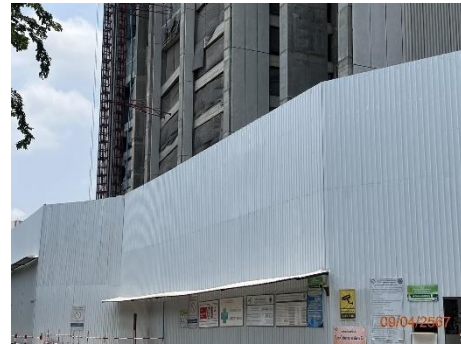
ภาพที่ 3.2.2-2 รั้ว Metal Sheet ตามแนวเขตพื้นที่ก่อสร้างโครงการ
